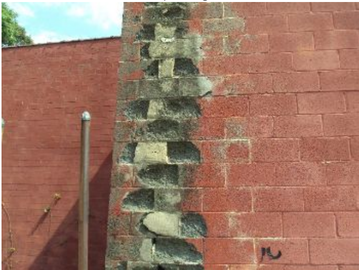
Spalling
