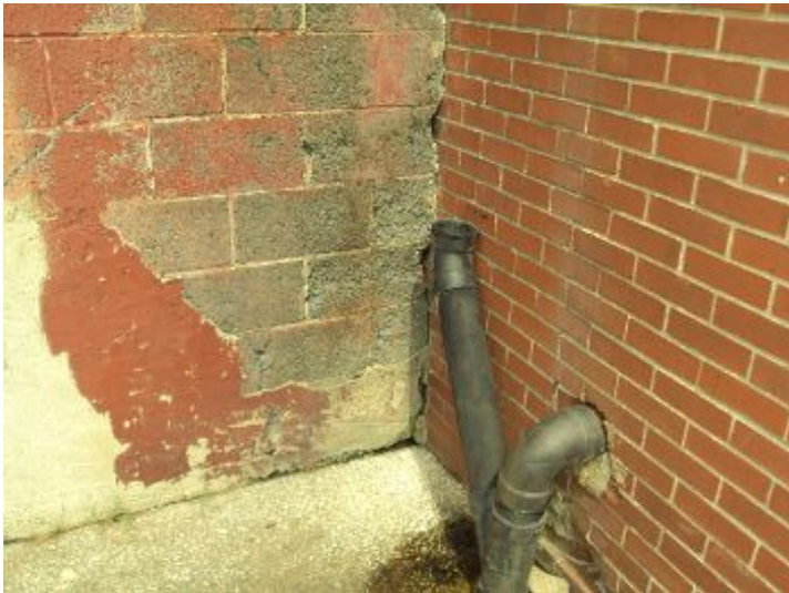
Spalling
